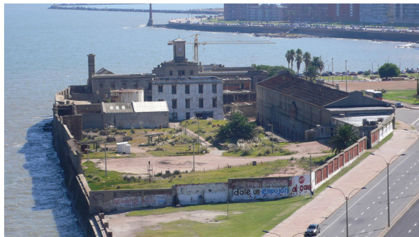
Predio de la ex-Compañía del Gas, dónde se instalará el Museo del Tiempo
